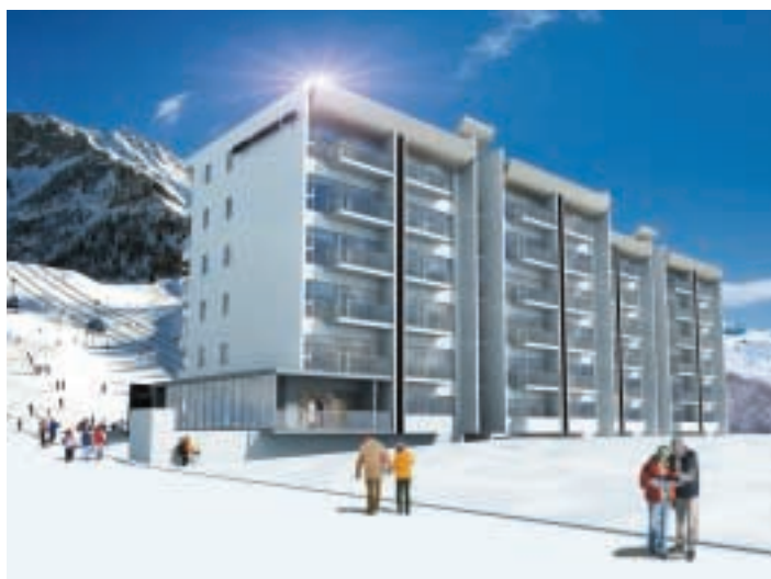
※完成予想図（CG）：9月現在の図面を基に作成したもので、実際と異なる場合があります。
