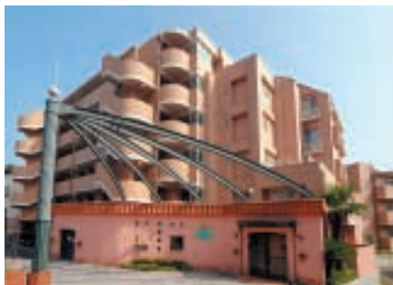
「ランドコム富岡」平成13年竣工
