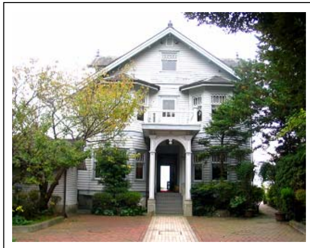
外観写真(改装前/撮影2006年8月)
